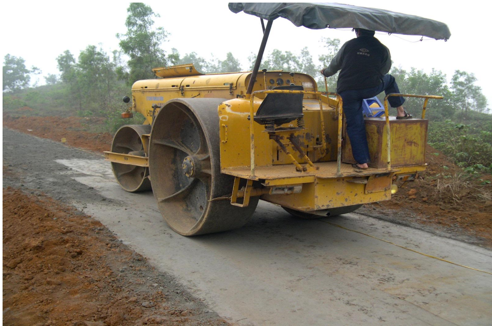
Ảnh 1, 2, 3. Thi công móng đường sử dụng HRB để cải tạo đất
