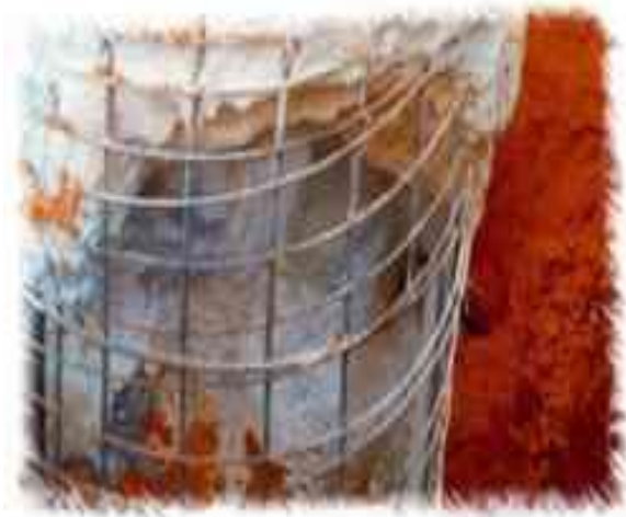
Khuyết tật nghiêm trọng mà phương pháp thử động biến dạng nhỏ có thể phát hiện được
